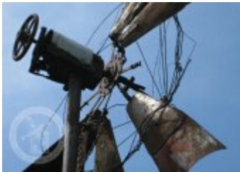
Současné fotografie - exteriér - detaily stavebních prvků
