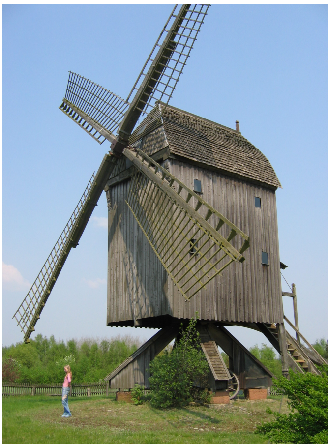
Jako první byl v současném areálu Mezinárodního muzea mlýnů v Gifhornu postaven tento dřevěný mlýn německého typu, který se proti větru natáčel celý. Foto: B. Koč
