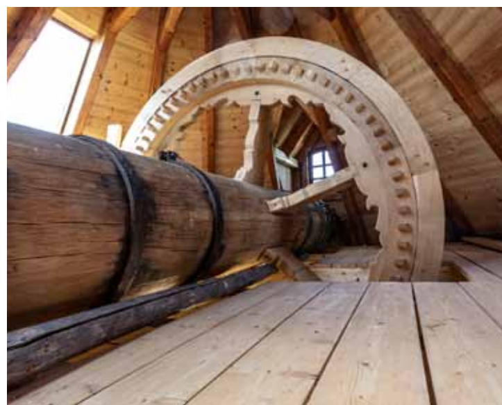
Poslední patro jako hostinský pokoj s viditelným mlýnským mechanismem u stropu. Na spodním obrázku pak detail hlavního hřídele s palečným kolem a brzdou
