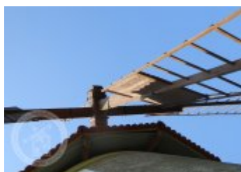
Současné fotografie - technologické vybavení
