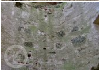
Současné fotografie - exteriér - detaily stavebních prvků
