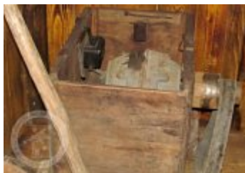
Současné fotografie - exteriér - detaily stavebních prvků
