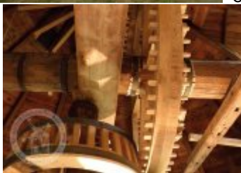
fotografie - technologické vybavení
