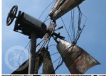
Současné fotografie - exteriér - detaily stavebních prvků
